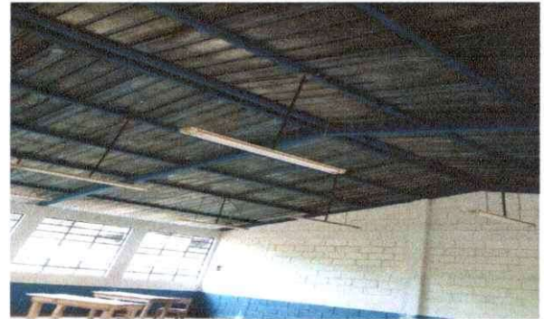
Foto 4: Mano de obra especializada (herrero) modulo 1
