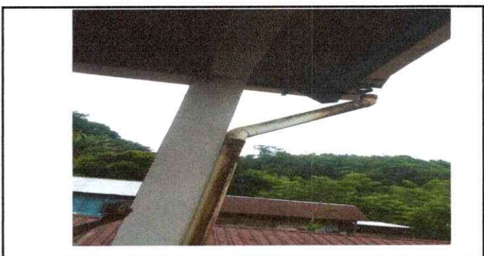
Foto 5: Canales y bajada de aguas fluvial modulo 1
