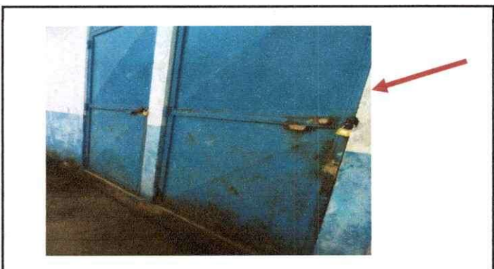
Foto 3: Mantenimiento de puertas modulo 2
