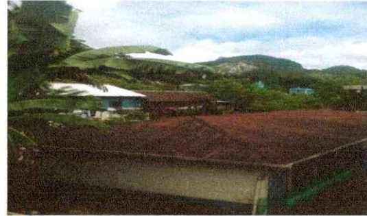
Foto 7: Aplicación de pintura exterior e interior. Modulo 3.
