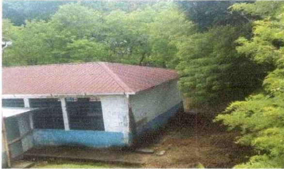
Foto 6: Aplicación de pintura exterior e interior. Modulo 2.
