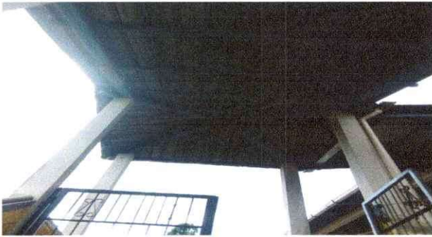
Foto 3: Mano de obra especializada (herrero) modulo 1
